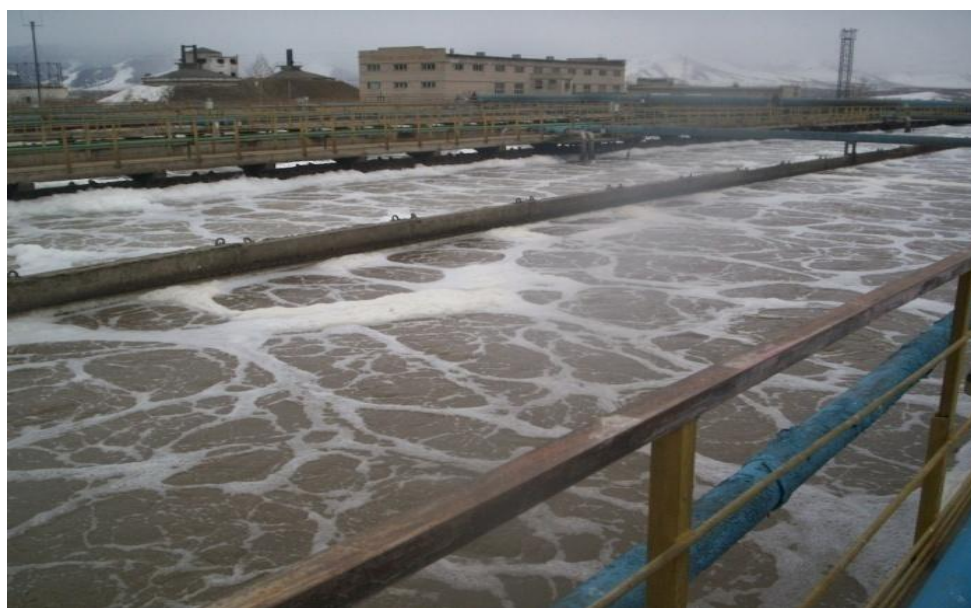
Рис. 4.4.2.c Центральная водоочистная станция г. Улан-Батора, Монголия. Фото: Г. Тамир.
