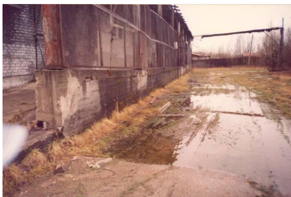
Рис.7 Склад до ремонта
