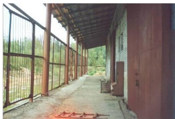
Рис.8 Склад после ремонта
