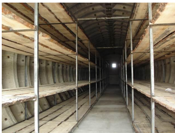
Рис. 5. Ангар, оборудованный для хранения ЗУП, Алтайский край
