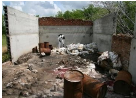
Рис.3 Разрушенный склад в Красноярском крае
