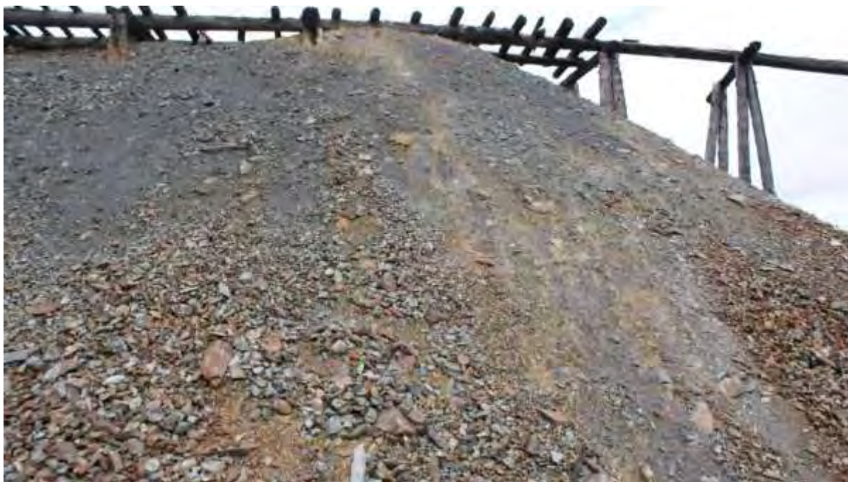
Фото 14. Отвал у штольни № 2
